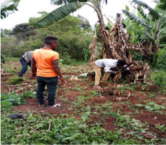
ምስል 6:- በከተማው ቦጨሳ-ጎልባ፣ ዌኔ-ጎዲሾ እና ዳሞ ቀበሌዎች ላይ የመንገድ ከፈታና ንብረት የማንሳት ሥራ ሲከናወን
